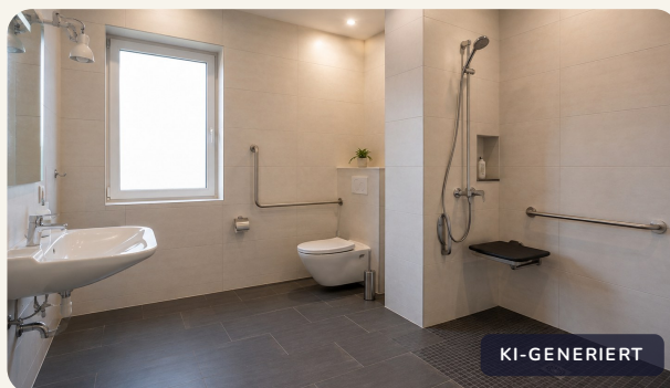
Bodengleiche Dusche, Haltegriffe, unterfahrbares Waschbecken – Beispiel einer barrierefreien Anpassung.
